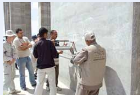
写真-2 現地調査風景
