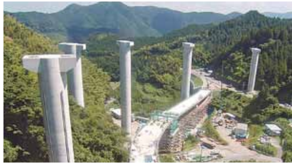
写真-1.5.21 3H工法
