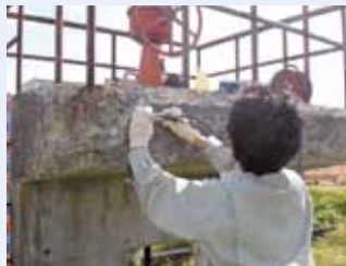
超音波を用いた劣化度評価の実習状況
