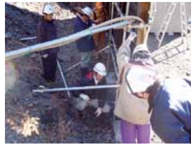
現場実証試験の実施状況
