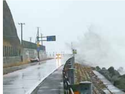
海岸道路における高波時の越波状況
