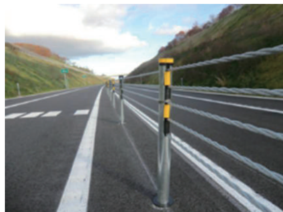
図-16.4 車線逸脱防止対策技術の導入例
