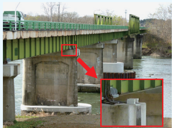
写真-2 橋梁地震被災度判定システムの適用状況
