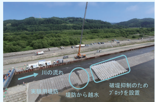
写真-1 水位が上昇し堤防から越水
