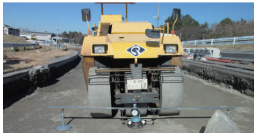
試験舗装区間での平板載荷試験
