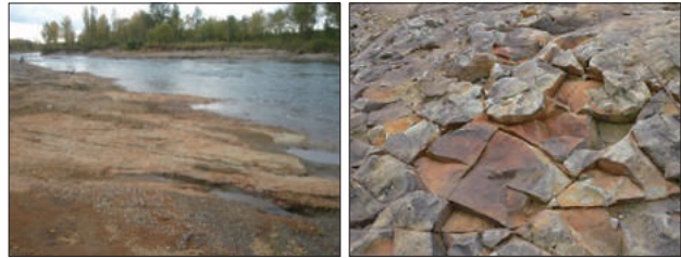
乾湿繰返しにより表層が劣化した岩床
