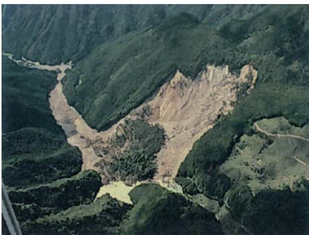
写真-1.3.2 土砂崩壊で発生した天然ダム
