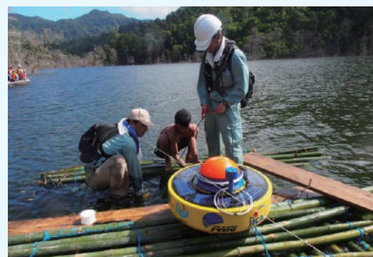
写真-3 水位観測ブイの設置状況
