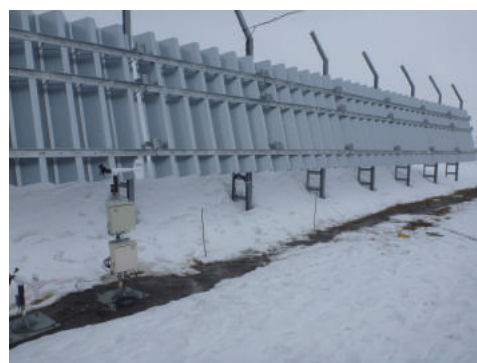
実物大新型柵を用いた現地試験
