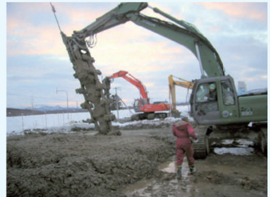
写真-2 新しい地盤改良技術 （トレンチャー式中層混合処理工法）
