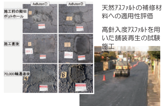
未利用アスファルト資材の適用性評価
