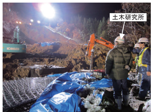
写真-1.3.6 不安定土砂の掘削方法の指導
