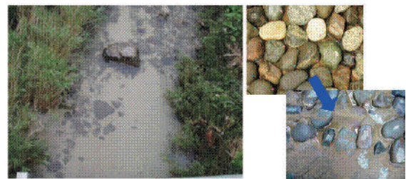
図-9.2 流域からの土砂の流出の影響を受けた河床
