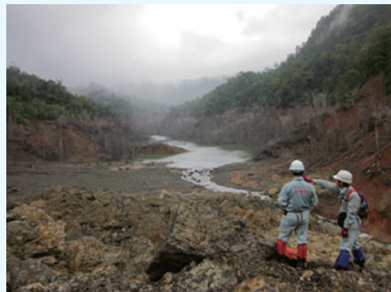
写真-4 決壊後の天然ダム現地調査状況
