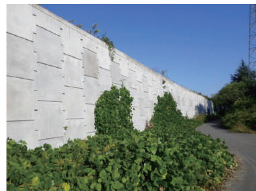
土工構造物の例：補強土壁
