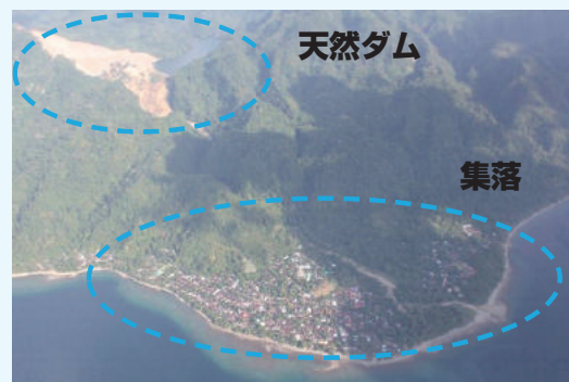
写真-1 アンボン島で発生した天然ダム
