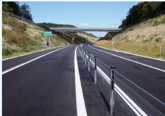
写真-2 道央自動車道における設置状況
