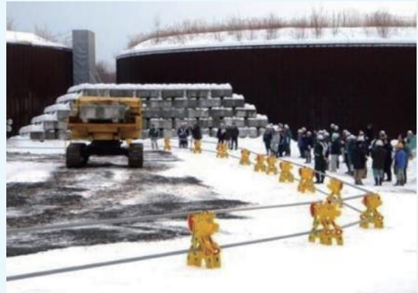
写真-2 無人クローラダンプによる運搬作業
