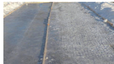
図-16.12 雪氷路面の施工前と施工後
