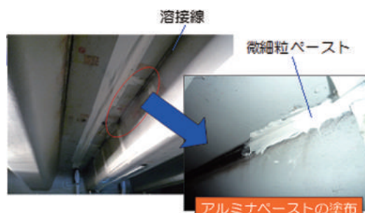
微細粒（アルミナ）を用いた疲労き裂の進展遅延化技術
