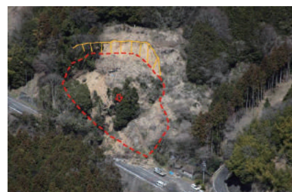
図 -3.12 地震による斜面地盤変状の例 (流れ盤の地質構造によるすべり)
