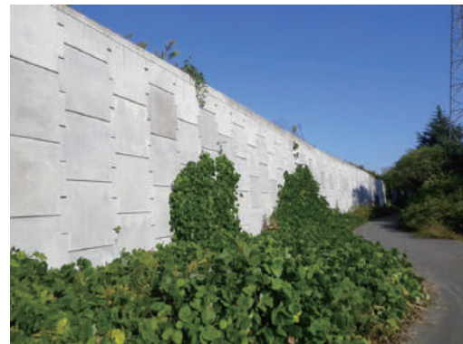
土工構造物の例：補強土壁
