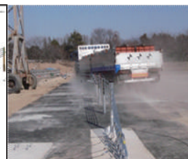
図-16.9 性能確認試験
