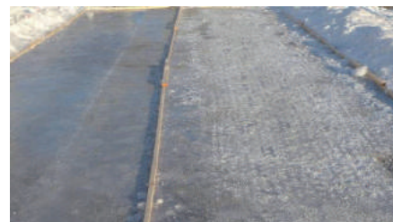
図-16.12 雪氷路面の施工前と施工後
