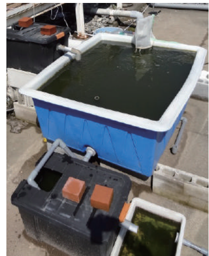
藻類を活用した下水処理法の実証装置
