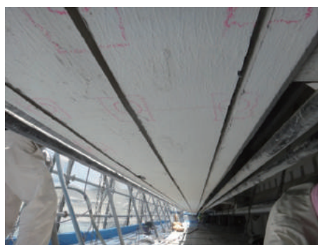
電気防食の施工
