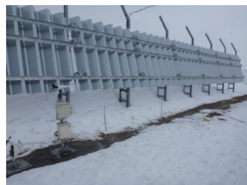
実物大新型柵を用いた現地試験
