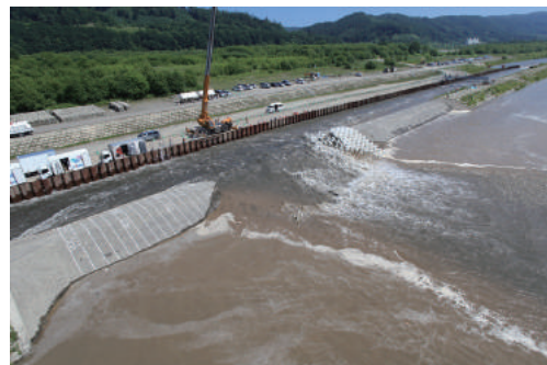
破堤拡幅がブロックに到達後、拡幅速度は遅くなっている
