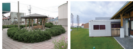
▲設計の問題で利用されない四阿の事例(左) 増築で園地が利用できなくなった事例(右)
