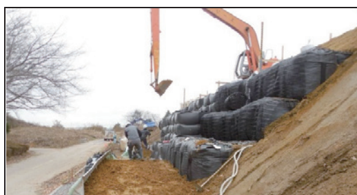
図-2.8 実大実験による施工状況
