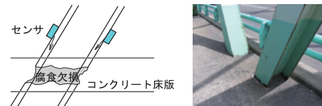
目視困難な部位の例（コンクリート埋込部の橋梁部材の腐食）
