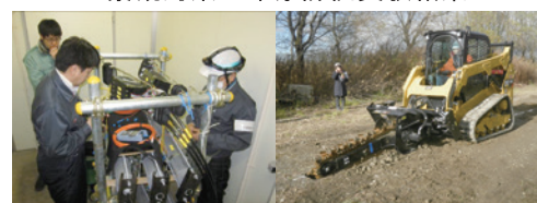
▲左) 管路供試体の通信性能計測状況 右) 掘削機械の試験施工状況
