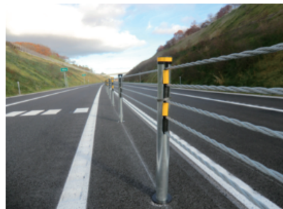
図-16.4 車線逸脱防止対策技術の導入例
