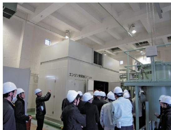
写真-1.3.13 現場見学の状況
