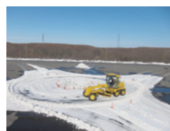
モーターグレーダによる除雪作業
