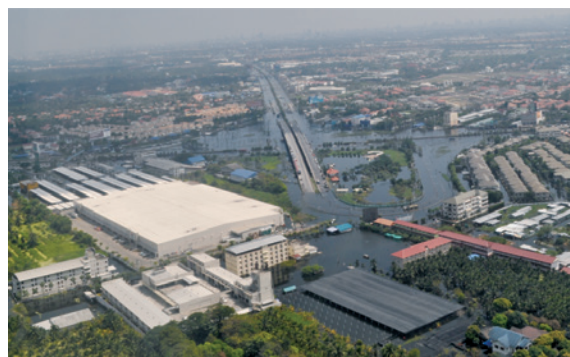
写真-1.3.11 水没する工業団地 (ICHARMの職員が上空から撮影)
