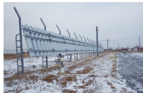
実物大新型柵を用いた現地検証試験
