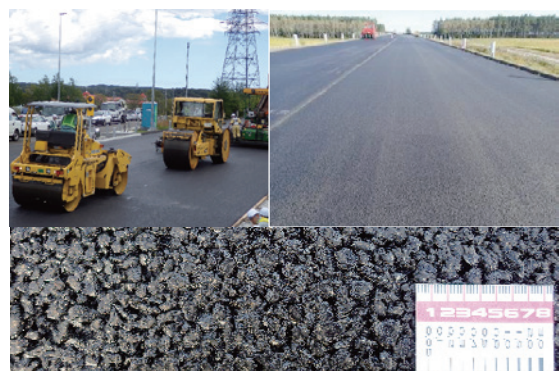
機能性（北海道型）SMA の試験施工の状況
