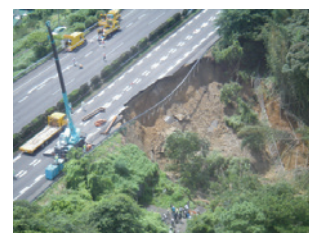
(b) 東名高速牧之原の盛土崩壊(2009年駿河湾を震源とする地震)
