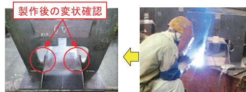
製作後の変状確認 構造詳細に対する施工性の確認試験
