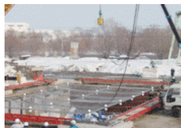
大型衝撃載荷実験状況
