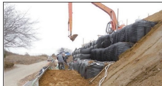
図-2.8 実大実験による施工状況
