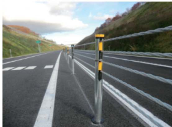
図-16.4 車線逸脱防止対策技術の導入例
