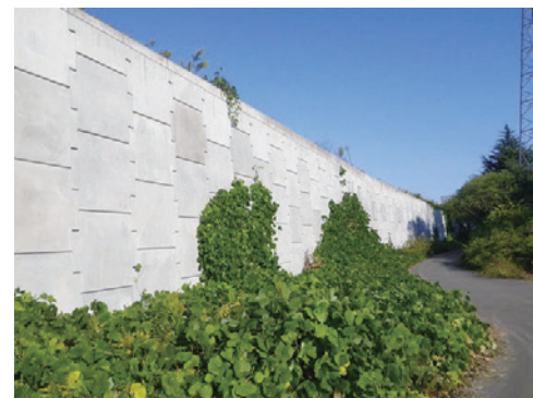
土工構造物の例：補強土壁
