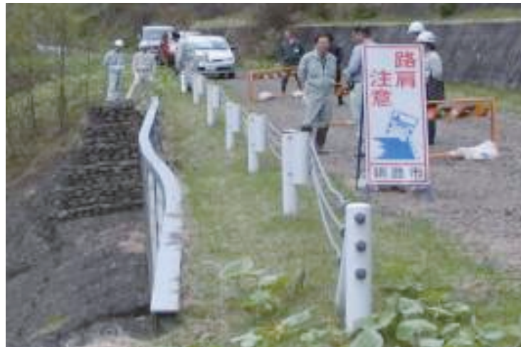
写真-1.3.9 法面変状に関する現地調査状況
