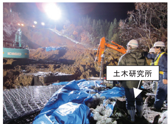
写真-1.3.6 不安定土砂の掘削方法の指導
