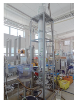
散水ろ床実験装置の外観
