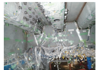
当て板設置状況
