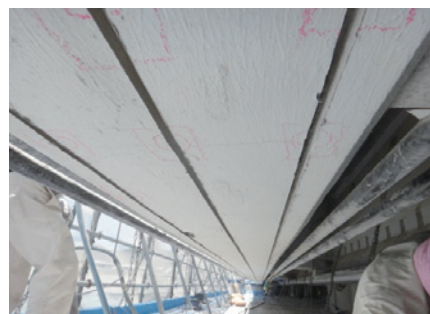
電気防食の施工
