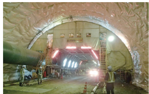
覆工の品質向上対策の事例（養生）
