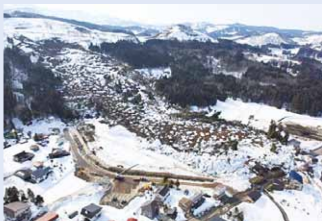
写真－1 地すべりの全景(新潟県撮影)
