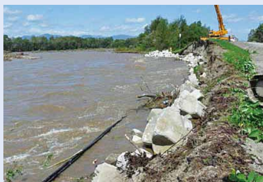
写真-2 根固めブロック投入状況
