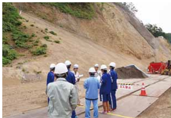
写真-1.5.4 道路法面の切土工事の現場見学
