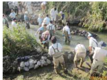
現場でのバープ作業状況
