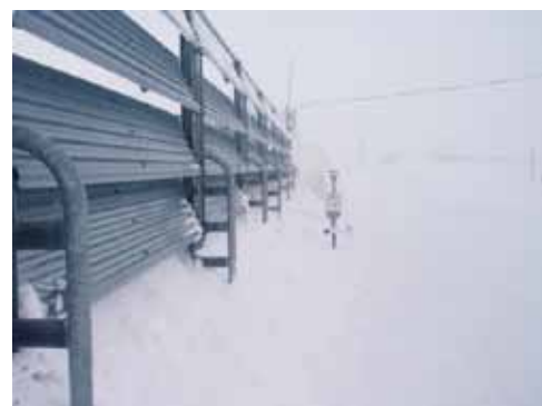
吹き払い柵周辺での防雪機能調査状況
