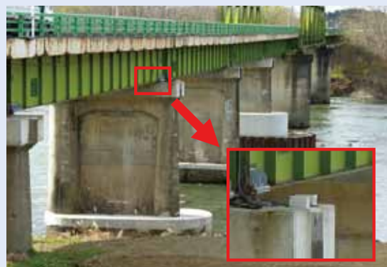
写真-2 橋梁地震被災度判定システムの適用状況
