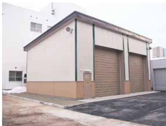
写真-8.1.6 実験装置格納庫
