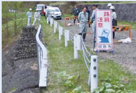
写真-1 法面変状に関する現地調査の様子
