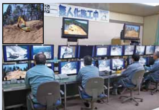
写真-2 無人化施工の遠隔操作 ※写真：株式会社熊谷組から提供
