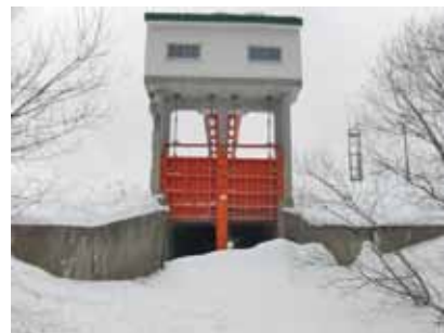
冬期樋門の現況(例)
