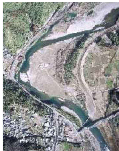
図8.1 高水敷の切り下げと樹木管理 切り下げ前(上)、切り下げ後(下) 高水敷を切り下げた後の再樹林化をどう抑制するかは治水・環境・維持管理の観点から重要な課題となっている。
