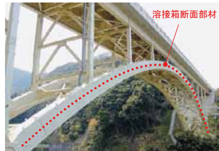
溶接箱断面圧縮部材の適用例
