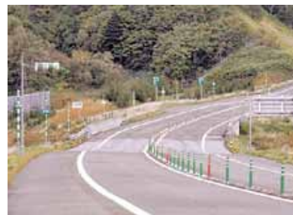
図14.3 泥炭地盤上の道路の不同沈下
