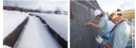
図-1 冬期の開水路 図-2 表面走査法の実施状況
