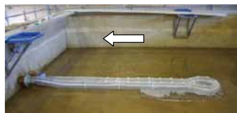
管径200mmの排砂管の設置状況
