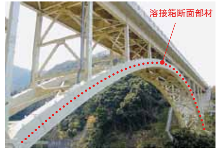
溶接箱断面圧縮部材の適用例
