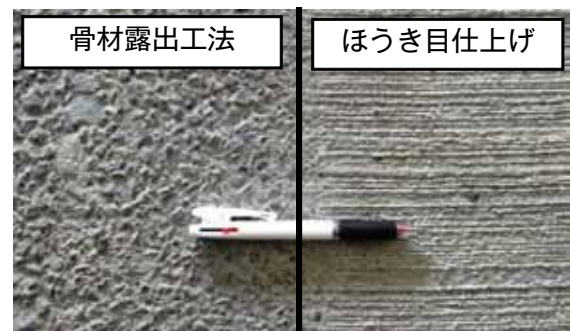
骨材露出工法とほうき目仕上げ
