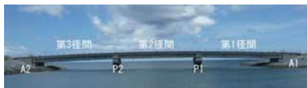
上部工調査対象橋梁 結橋の全景
