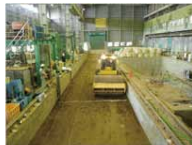
転圧試験の様子
