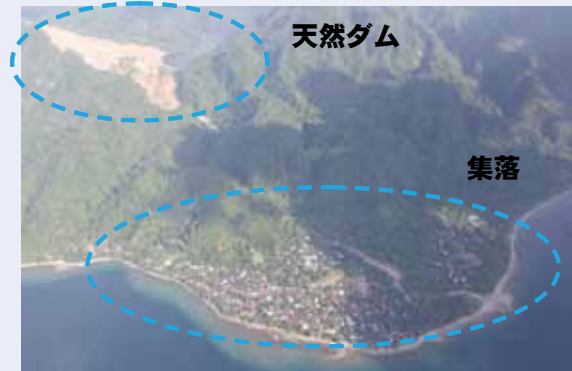
写真-1 アンボン島で発生した天然ダム
