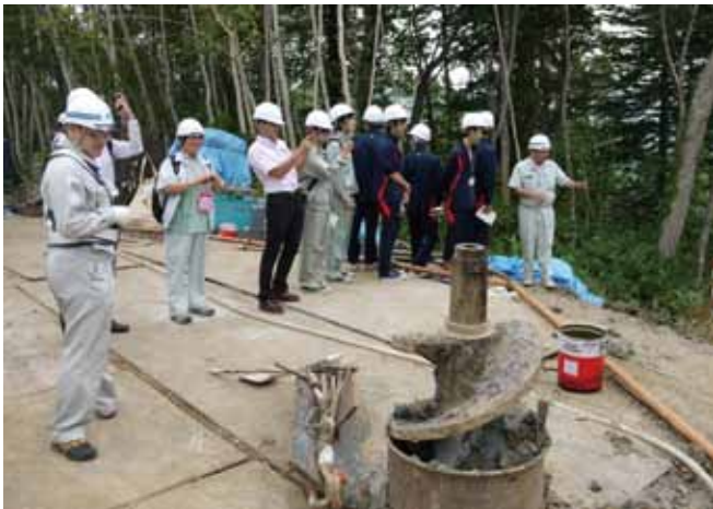
写真- 1.5.2 工事現場見学
