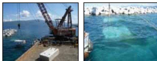
図-3 実証試験（嵩上げ施工）
