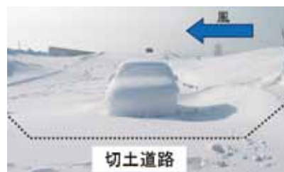
切土道路の吹きだまり状況の例
