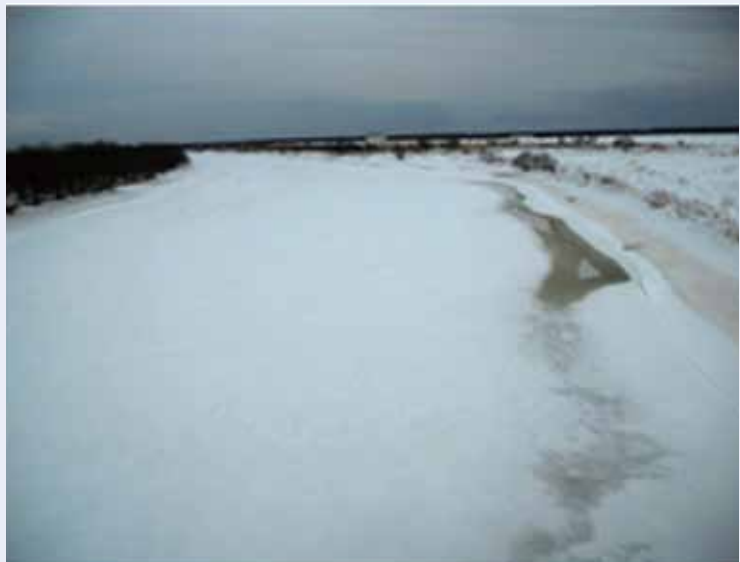
写真－2 結氷する河川（浦幌十勝川 北海道）
