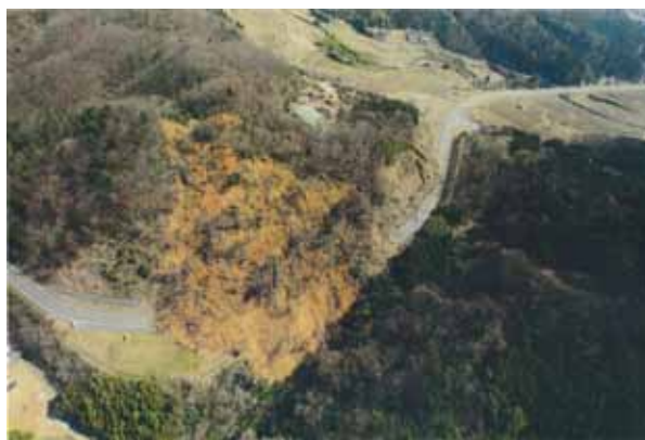
図 2.4 東北地方太平洋沖地震における県道の被災事例（管轄事務所提供）
