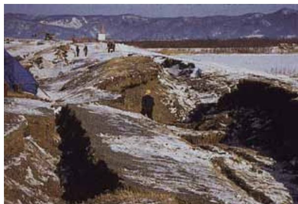
泥炭地盤上の河川堤防の地震被害
