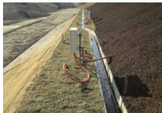
山側に施工したU型トラフ
