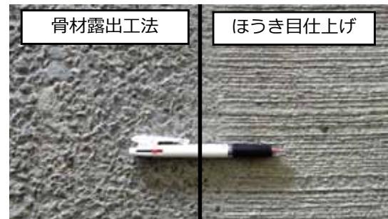
骨材露出工法とほうき目仕上げ
