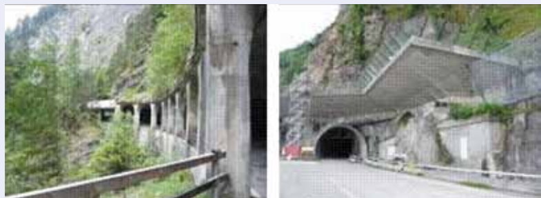
写真－2 スイスの落石覆工の例
