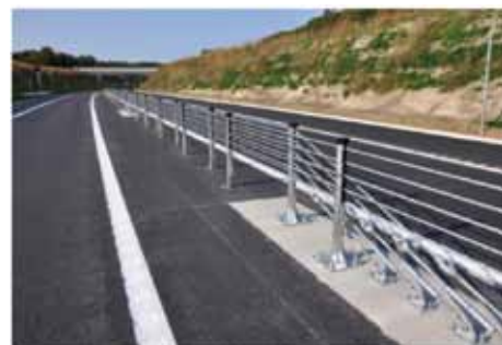
写真 16.3 高速道路の中央分離帯へ導入されたワイヤーロープ柵
