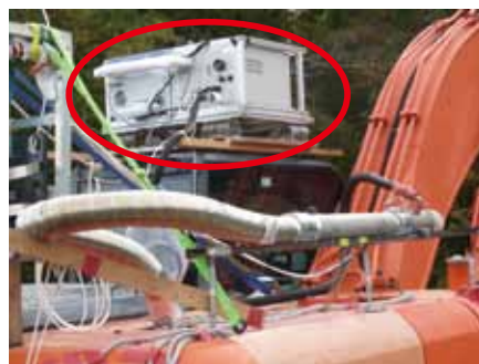
設置した車載型排出ガス計測装置の様子
