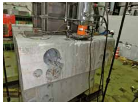
縁端拡幅補強部の耐荷力試験
