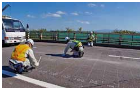
現地での床版上面調査の状況
