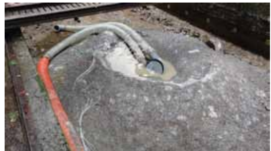
現地実証試験の状況 (上：排砂前、下：排砂・排水後)
