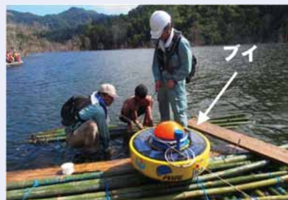
写真-3 土研式投下型水位観測ブイの設置状況
