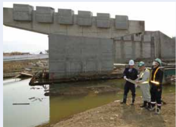
写真-1 橋梁の被害状況調査の様子
