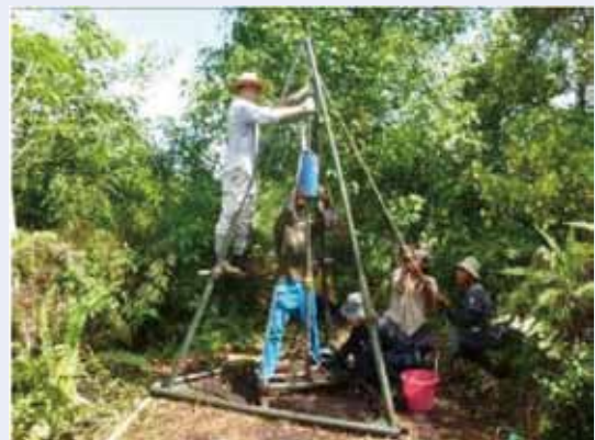
写真－1 現地調査の様子
