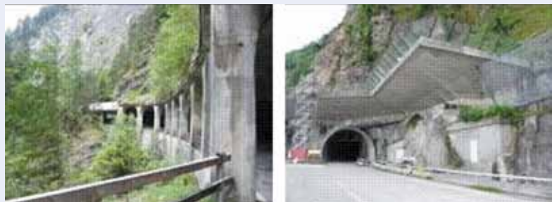
写真－2 スイスの落石覆工の例
