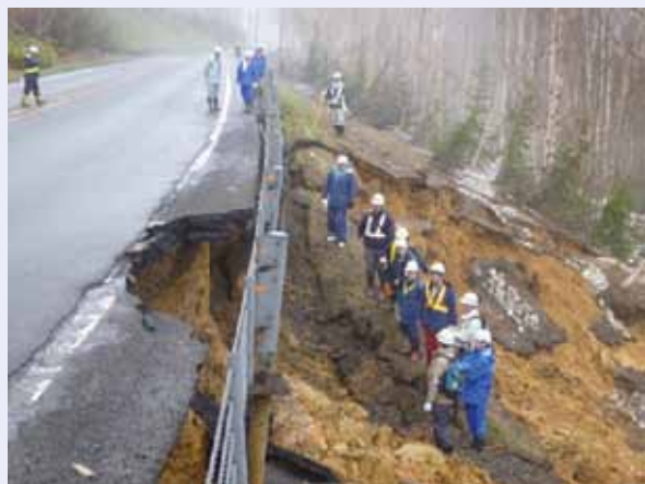
写真-4 現地状況(国道 230 号)
