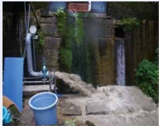
写真-2 排砂中の堰堤下流の状況
