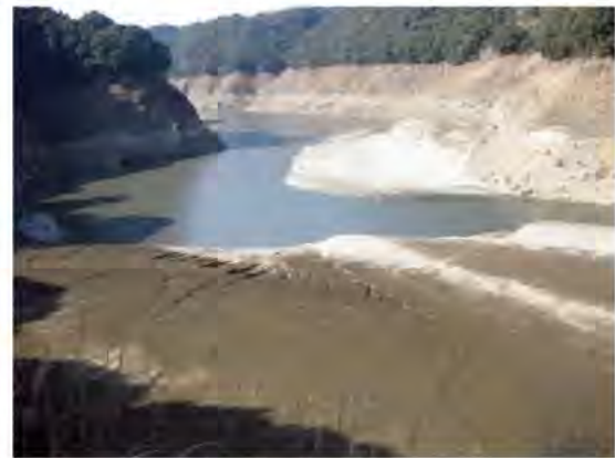
図-9.6 水位低下に伴う濁水発生状況
