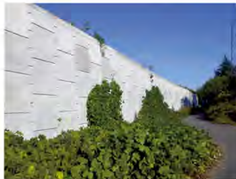
土工構造物の例：補強土壁
