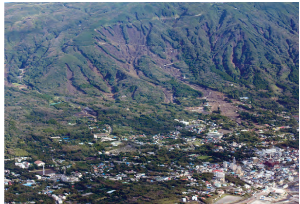
図-2.4 台風26号豪雨による伊豆大島の表層崩壊（関東地方整備局提供）
