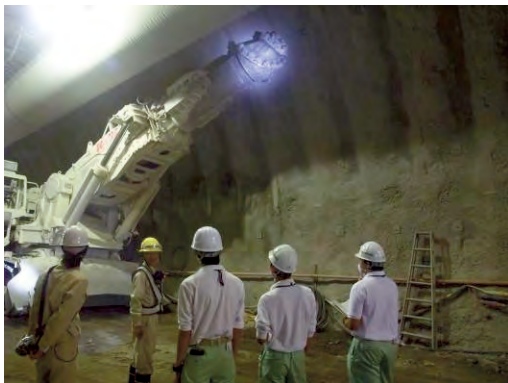
写真-1.5.2 トンネル工事現場見学
