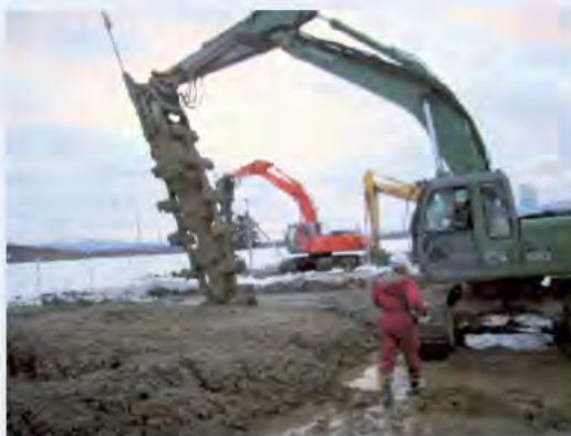
写真-2 新しい地盤改良技術 （トレンチャー式中層混合処理工法）
