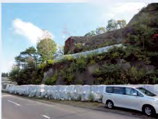
写真-3 恵庭市の道路斜面応急対策
