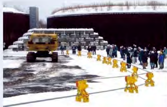
写真-2 無人クローラダンプによる運搬作業
