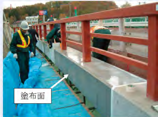
写真-2 試験施工の状況
