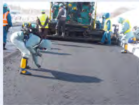
写真-2 中温化混合物の温度測定状況
