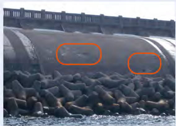
写真-2 ドーム外面の状況
