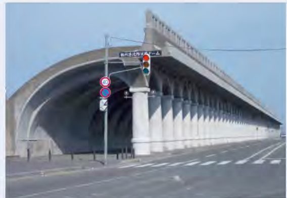
写真-1 稚内港北防波堤ドーム
