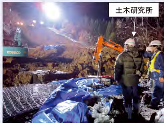
写真-2 不安定土砂の掘削方法の指導
