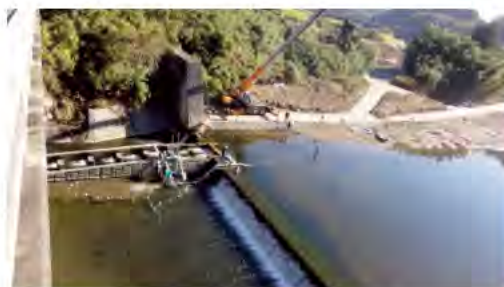
現地実証試験実施状況全景
