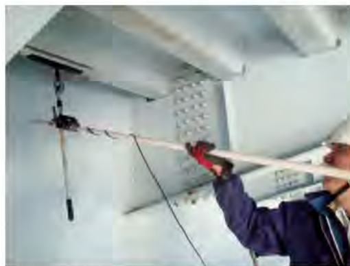
超音波を利用した鋼床版 Uリブ内滞水調査法の現場試行事例
