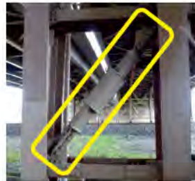
鋼材降伏系ダンパーの設置例
