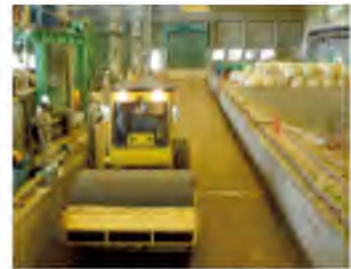
転圧試験の状況（大型機械）
