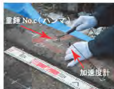
現場での床版上面調査の状況
