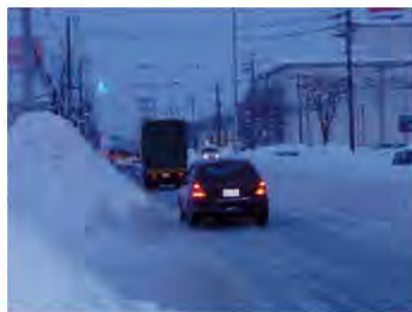
路肩雪堤による有効幅員の減少
