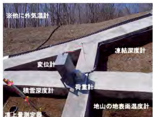
グラウンドアンカーにおける各計測状況
