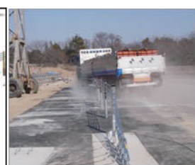
図-16.9 実車による性能確認試験
