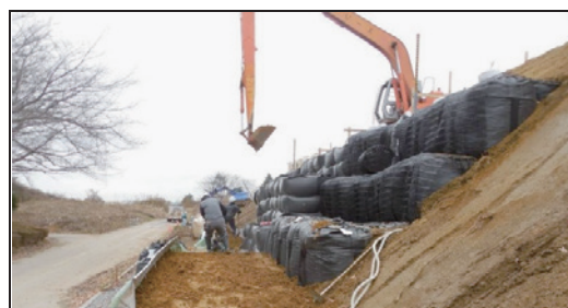
図-2.8 実大実験による施工状況
