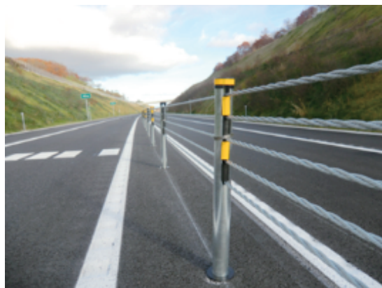
図-16.4 車線逸脱防止対策技術の導入例
