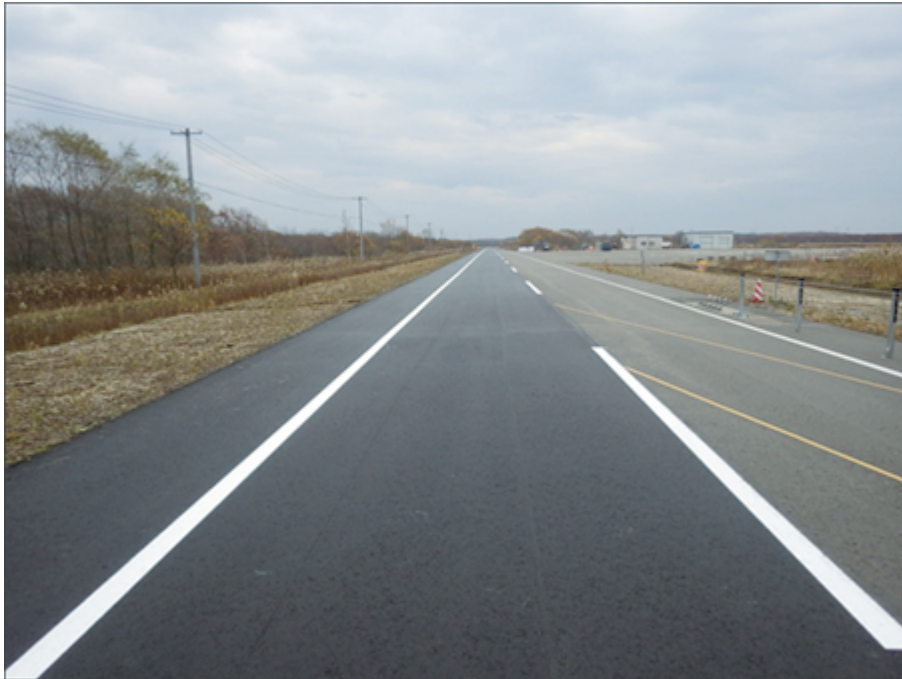
写真-8.1.6 苫小牧寒地試験道路改修
