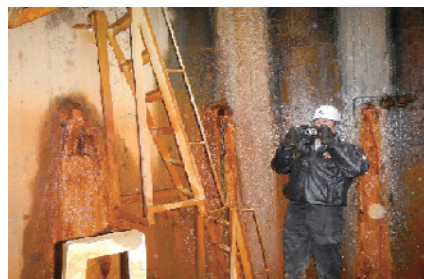
閉塞物質のある地下水排除工の調査
