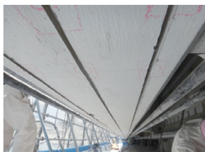
電気防食の施工
