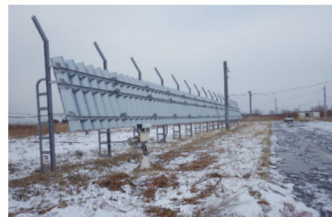
実物大新型柵を用いた現地検証試験
