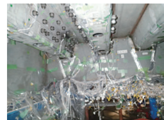
当て板設置状況
