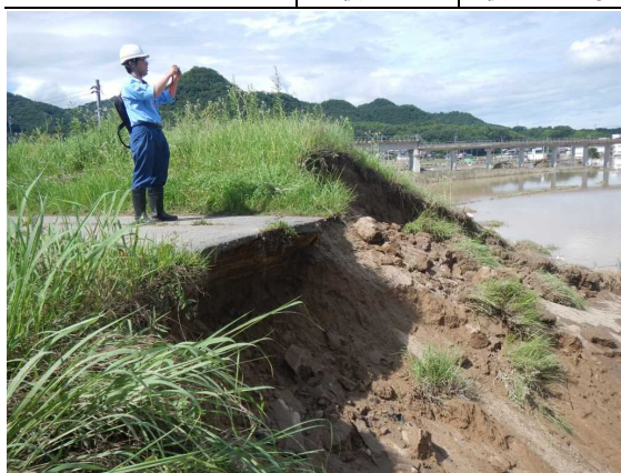
写真-1 小田川堤防決壊箇所の確認
