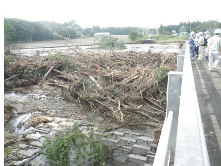
写真-1.1.3.6 R38 小林橋の現地調査状況
