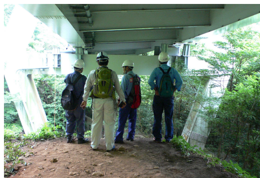
写真-1.1.3.2 被災橋梁の損傷状況調査
