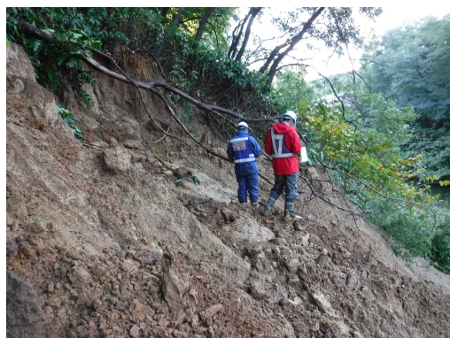
写真 - 1.1.3.10 表層崩壊箇所の調査の様子
