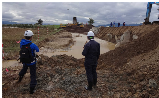
写真 - 1.1.3.18 千曲川における堤防の調査の様子
