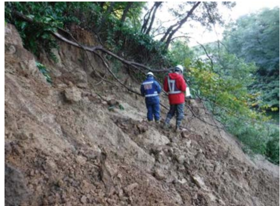
写真-1.1.3.4 表層崩壊箇所の調査の様子
