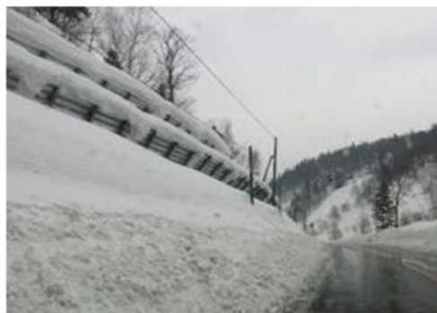
雪崩予防柵に発生する巻きだれ
