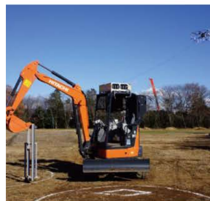
図-9 遠隔操作式小型油圧ショベルと有線給電UAV
