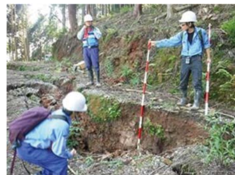
写真-1.1.3.2 地すべり箇所の調査の様子
