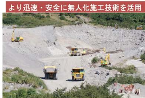
図-4 土砂災害の防止・軽減のために開発するロボット技術
