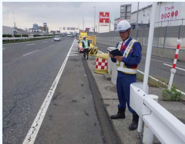
写真-2 現場での舗装点検必携の活用
