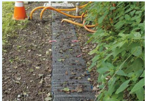
写真-3 設置後2年目（H29.7）の状況
