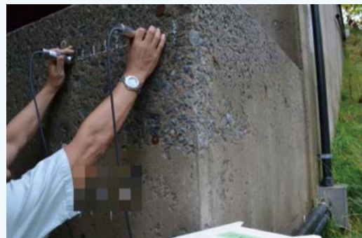
写真-1 表面走査法による調査状況
