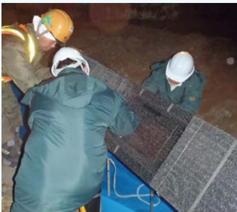
写真-2 人力による設置状況
