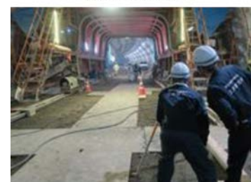
現地計測の状況
