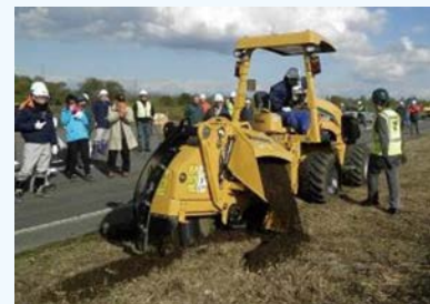
写真-2 トレンチャーによる掘削作業状況
