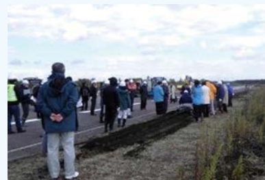
写真-3 掘削溝復旧試験の見学状況
