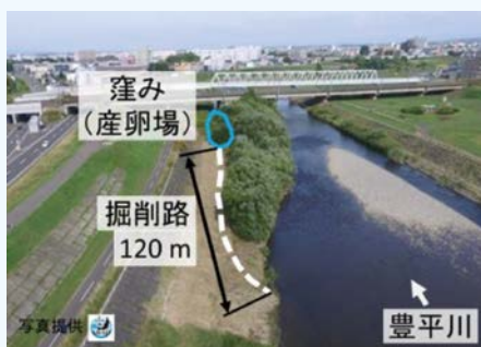
写真-3 寄州上流部に造成した掘削路
