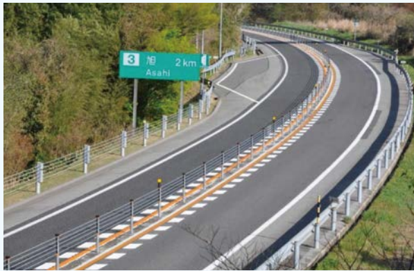
写真-1 高速道路暫定2車線区間設置状況
