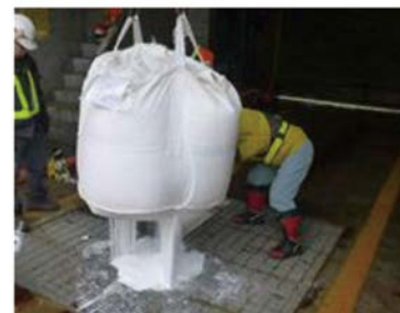
散布水溶液作製状況 (NEXCO 中日本)
