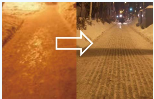
写真-4 施工前と施工後の状況
