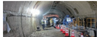
図-6 インバート追加設置の試験施工
