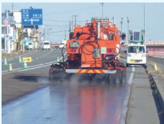
写真-3 フォグシール施工状況
