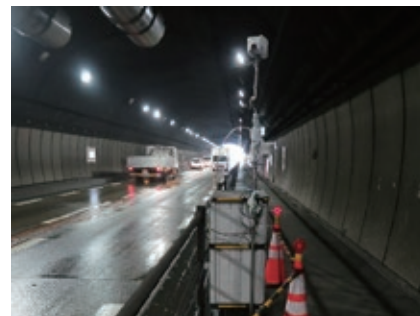
写真 換気実態調査の状況
