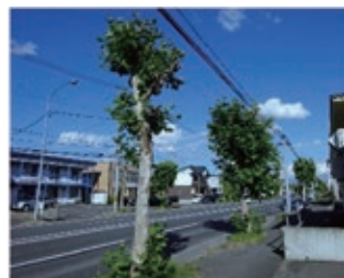
歩道幅員に適さない樹種を植栽したことにより強剪定されている事例
