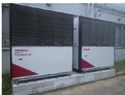
土木研究所研究本館空調設備更新
