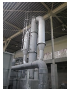
水理実験施設給水配管・定圧塔更新
