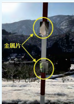
写真-3 金属片の設置状況（本線スノーポール） 中日本高速道路株式会社HPより
