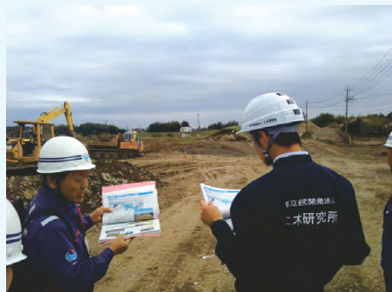
写真-2 那珂川右岸28.6kの調査状況
