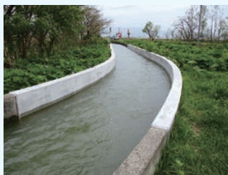
写真-1 試験施工を実施した用水路
