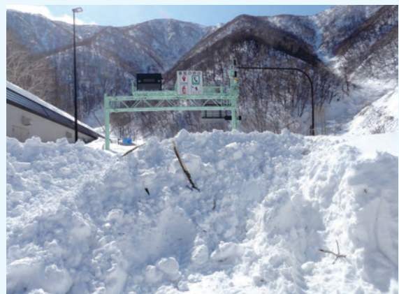
写真-2 国道236号野塚峠の雪崩発生箇所の状況
