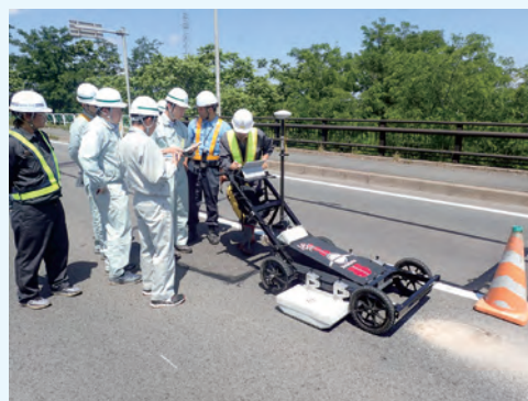
写真-1 道路橋床版の非破壊調査の状況 （現場での若手技術者も交えた意見交換）
