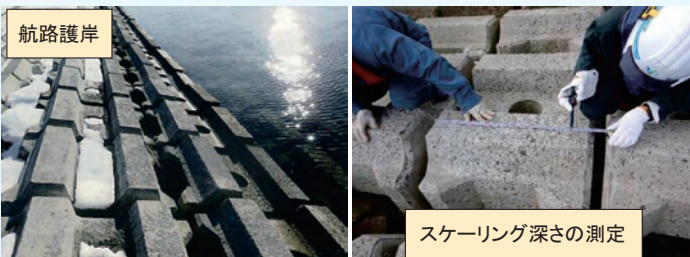
写真-1 航路護岸被覆ブロックでの調査状況
