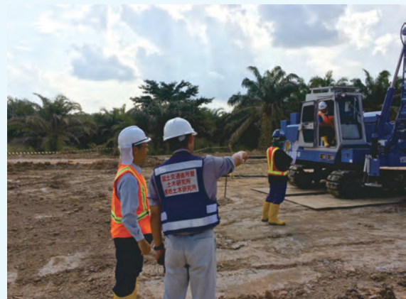
写真-2 JICAプロジェクトにおけるセメント安定処理工法の試験施工（スマトラ島）
