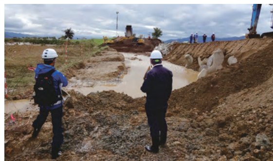
写真-1.1.3.2 千曲川における堤防の調査の様子
