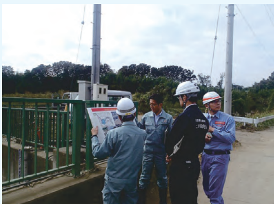
写真-3 埼玉県管理新江川決壊箇所の調査状況
