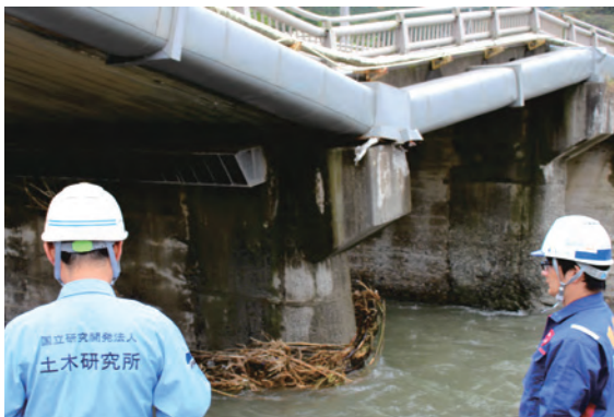
写真-1.2.3.1 被災橋梁の調査の様子 (一般国道20号 法雲寺橋 (山梨県大月市))
