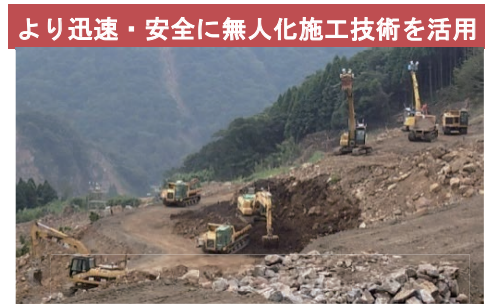
図-4 土砂災害の防止・軽減のために開発するロボット技術
