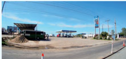
写真-2 技術指導したガスステーション活用の道の駅候補地
