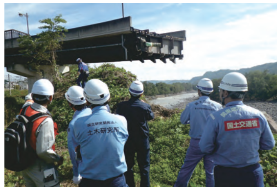
写真-1.2.3.2 被災橋梁の調査の様子 (市道 海野宿橋 (長野県東御市))
