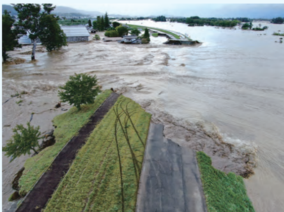
写真-1 千曲川左岸57.5kの堤防決壊の状況 (写真提供：国土交通省 北陸地方整備局)
