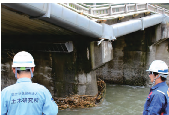
写真-1.2.3.1 被災橋梁の調査の様子 (一般国道20号 法雲寺橋 (山梨県大月市))
