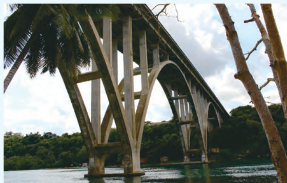
写真-2 アントニオギテラス橋
