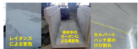
図-8 プレキャスト変状事例
