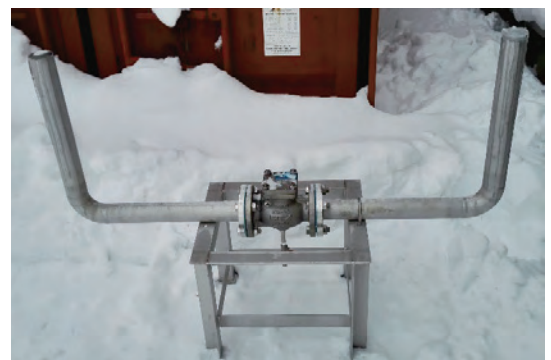
写真-2 設備改造実証試験 （バルブ部へのドレインの追加）
