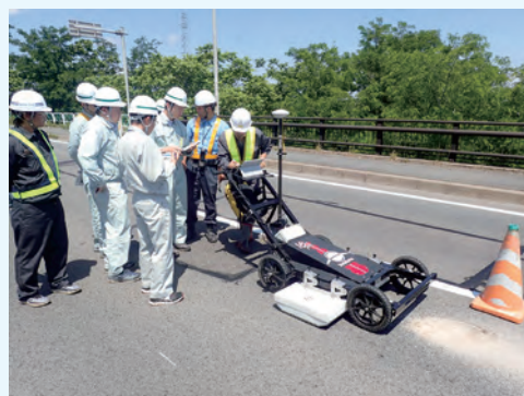
写真-1 道路橋床版の非破壊調査の状況 （現場での若手技術者も交えた意見交換）
