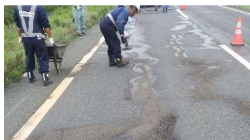
写真-2 フォグシールの施工状況
