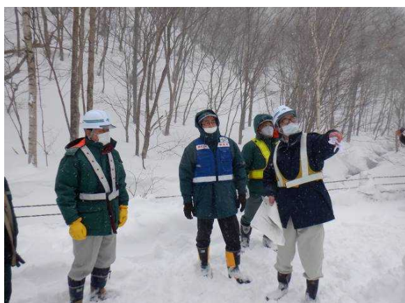
写真 - 1.1.3.3 国道5号（共和町）で道路管理者と打合せ
