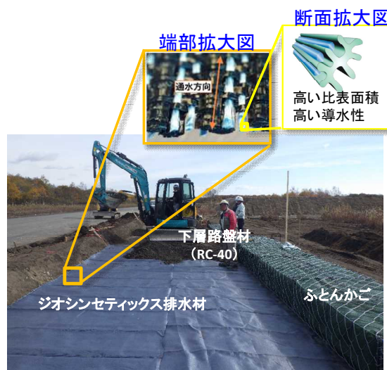
図-1 ジオシンセティックス排水材の設置例
