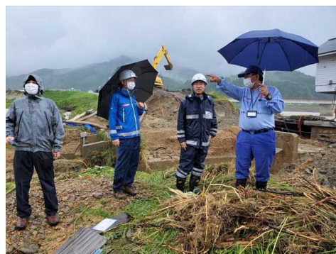
写真 - 1.1.3.2 土質・振動チームの調査の様子
