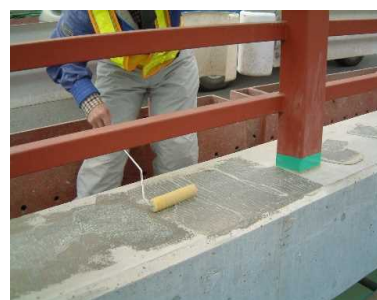
写真-2 シラン系表面含浸材の施工状況
