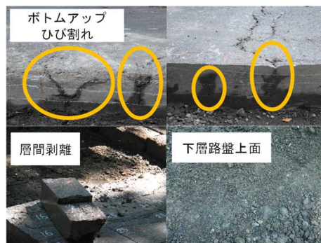
図-6 舗装開削調査の実施状況
