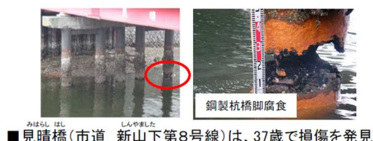
図-2 重大な損傷事例
