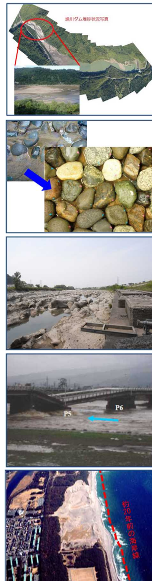
図-1 総合土砂管理による解決が必要とされる問題事例(上から、ダム堆砂、河床のアーマー化(粗粒化)、河床の低下・露岩化、橋脚周辺の局所洗堀、海岸砂浜の喪失)
