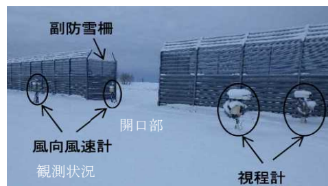
図-12 副防雪柵の現地計測
