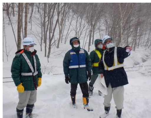
写真-2 現地調査における技術的助言の状況
