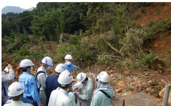
写真 - 1.1.3.1 地すべりチームの調査の様子
