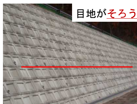
(b) 布積（控長を35cmのまま大型化したブロックの場合）
