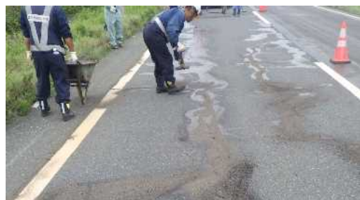
写真-2 フォグシールの施工状況
