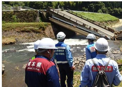
写真-1.2.1.8 落橋現場での技術指導状況
