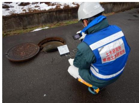
写真-1.2.1.6 農業集落排水施設における被害の調査状況
