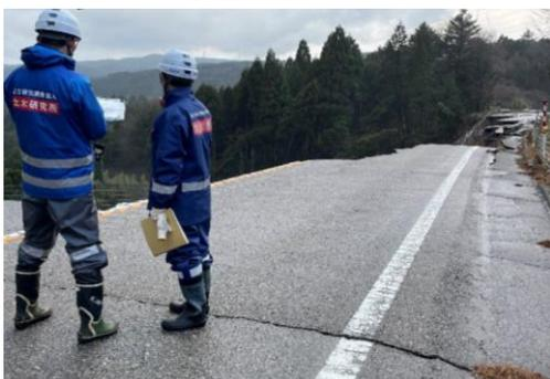
写真-1.2.1.3 崩壊した道路盛土の調査状況
