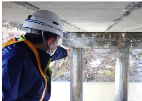
写真-1.2.1.2 損傷した橋梁下部の調査状況
