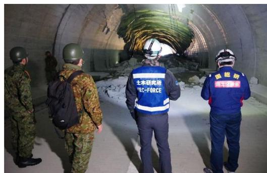
写真-1.2.1.4 大谷トンネルの覆工崩落箇所の調査状況
