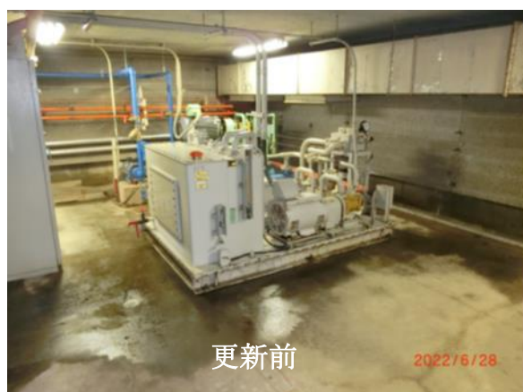
写真-8.1.1.1 構造物繰返し载荷装置油圧源外更新（つくば）
