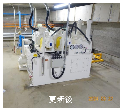
写真-8.1.1.1 構造物繰返し载荷装置油圧源外更新（つくば）
