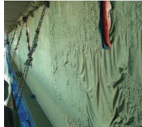
鋼橋塗装のライフサイクルコスト削減のため、一般塗装系塗膜を耐久性に優れた重防食塗装に塗り替える必要があります。本講演では、鉛・クロムなどの有害物質を含む一般塗装系塗膜を容易かつ確実に除去・回収できる、作業効率・環境安全性に優れた塗膜除去工法「インバイロワン工法」を施工事例を交えて紹介します。
