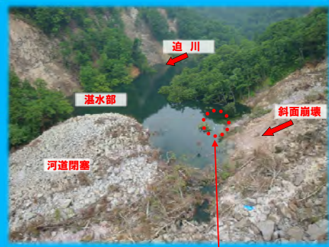
投下型水位観測ブイの設置位置
