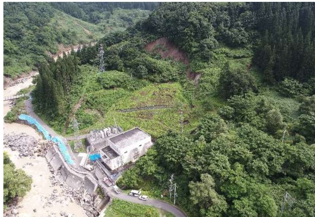
地すべり全景
