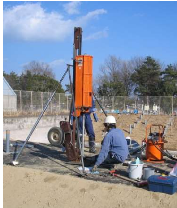
ラムサウンディング試験機 (打ち込み機械の例)
