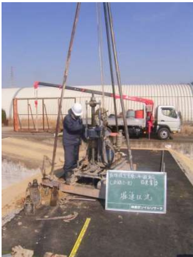
ボーリングマシンによる削孔
