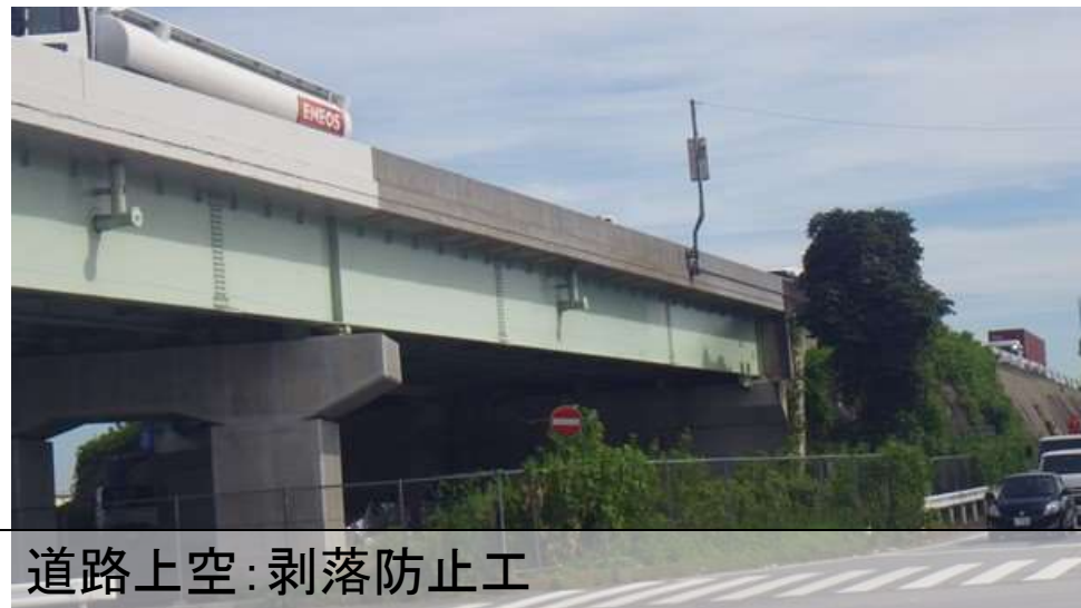
側径間：表面被覆工
