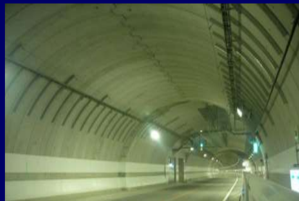
②完成写真
