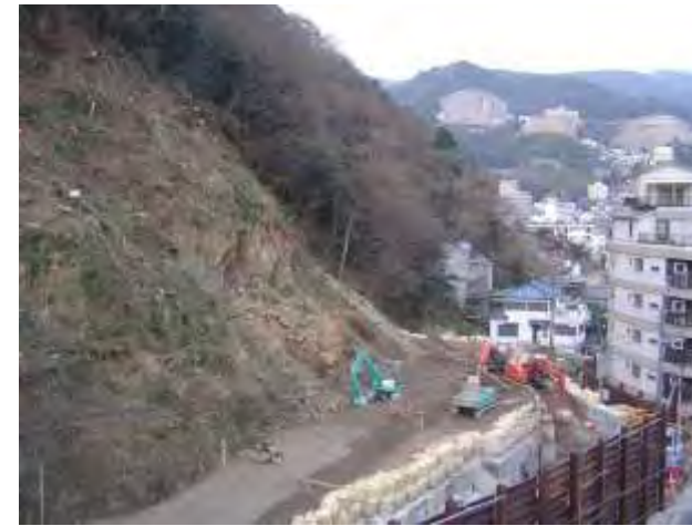
応急対策工事
