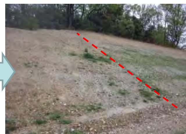
平成30年4月（施工後5ヶ月）
