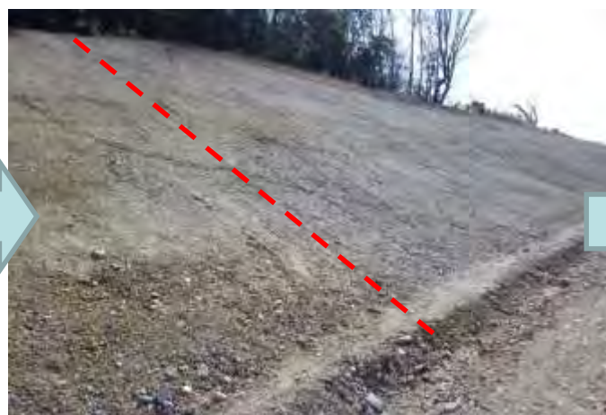
平成30年2月（施工後3.5ヶ月）
