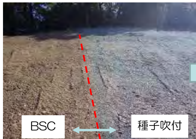
平成29年11月（施工時）
