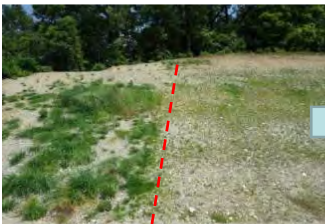
平成30年5月（施工後6.5ヶ月）
