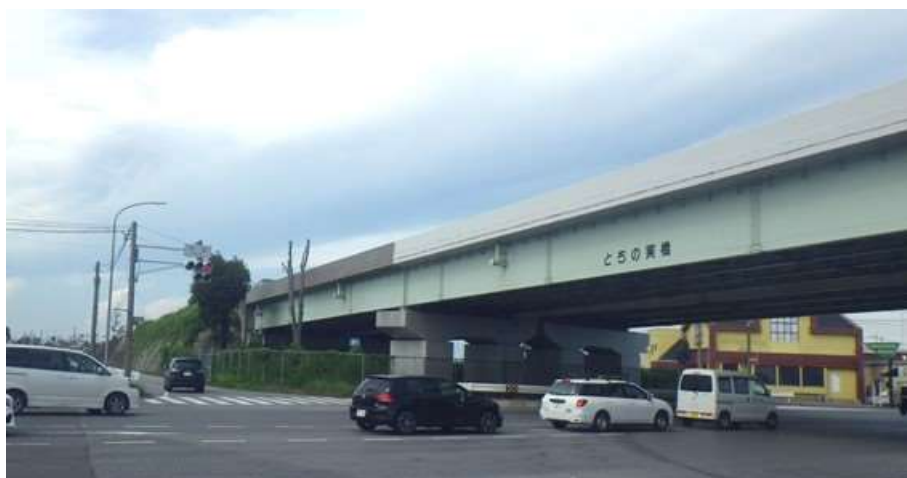
側径間：表面被覆工
