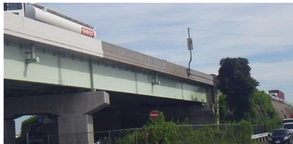
道路上空：剥落防止工
