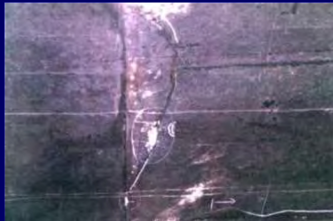
ひび割れと横断目地との 組合せで半月状にブロック化
