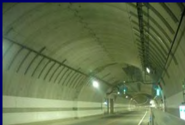
②完成写真
