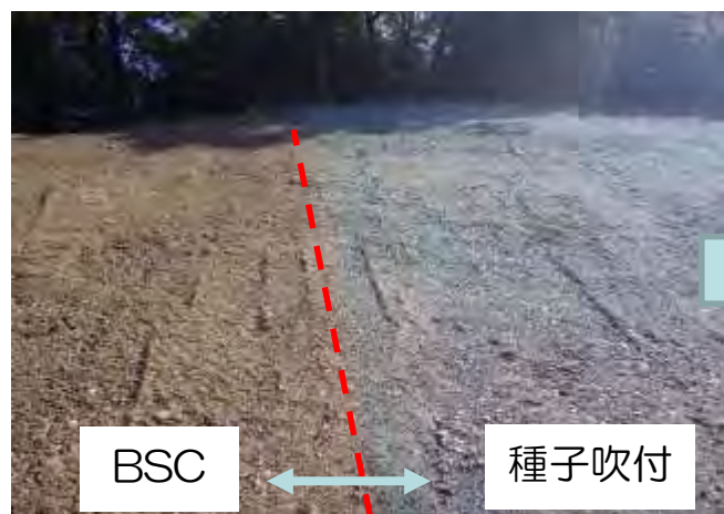
平成29年11月（施工時）
