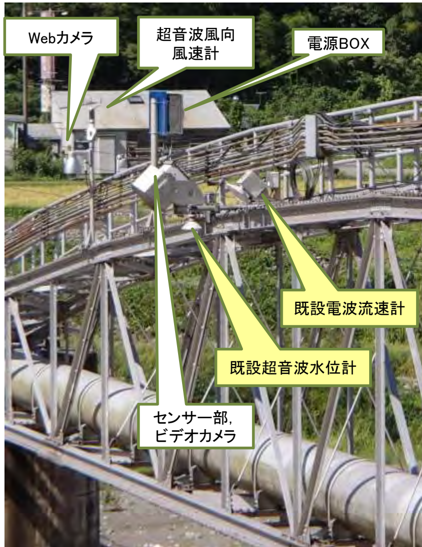
右岸(局舎近く)から撮影
