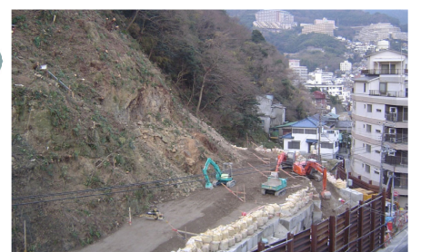
応急対策工事
