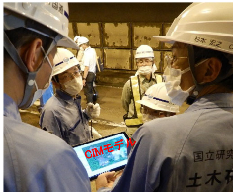
地すべりとトンネル位置の確認
