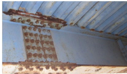
継手部（高力ボルトまわり）
