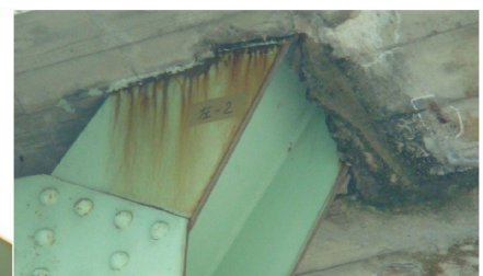
コンクリート埋設部
