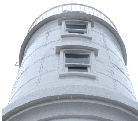
チタン箔シート貼付施工後近影
