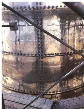
チタン箔シート施工時（塗装前）
