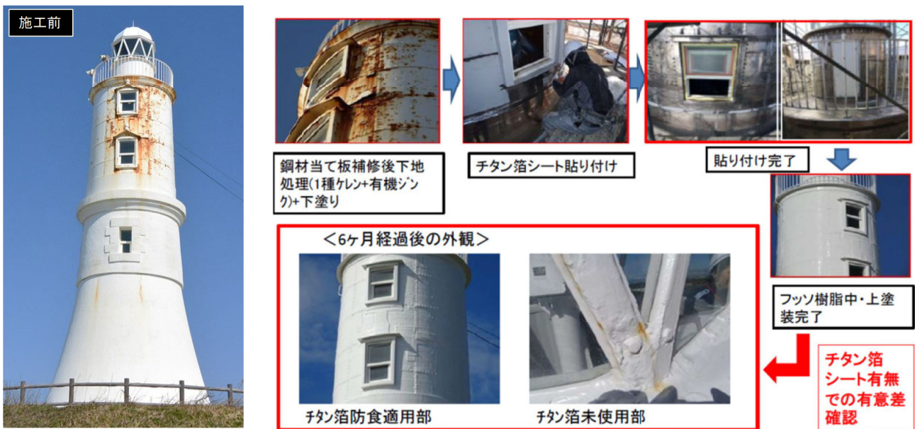
チタン箔シート貼付施工前外観
