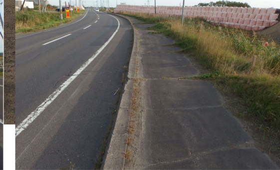
【L側現道部の状況】
