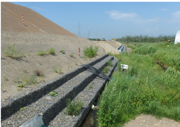
【L側盛土法尻部の状況】 (2019.8.1撮影)
